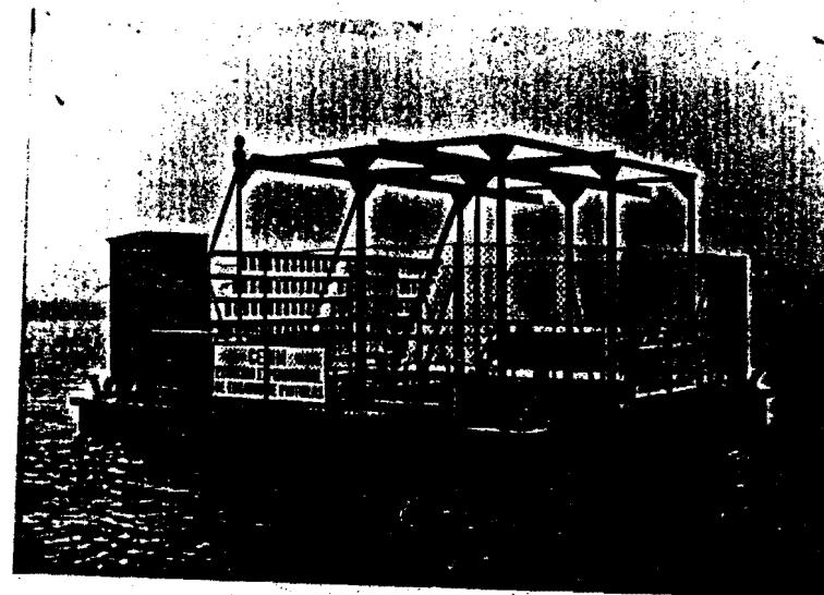
Fig. 1.- Vista de la balsa experimental para ensayos de pinturas en agua de mar.
